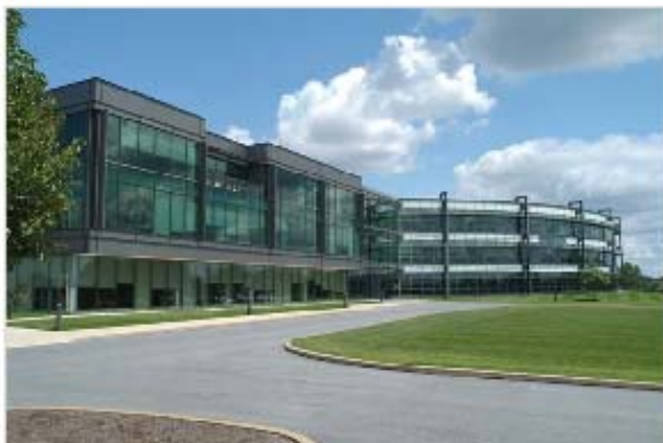
Las oficinas de Armstrong en Pensilvania tienen la certificación LEED Platino Foto: Armstrong
